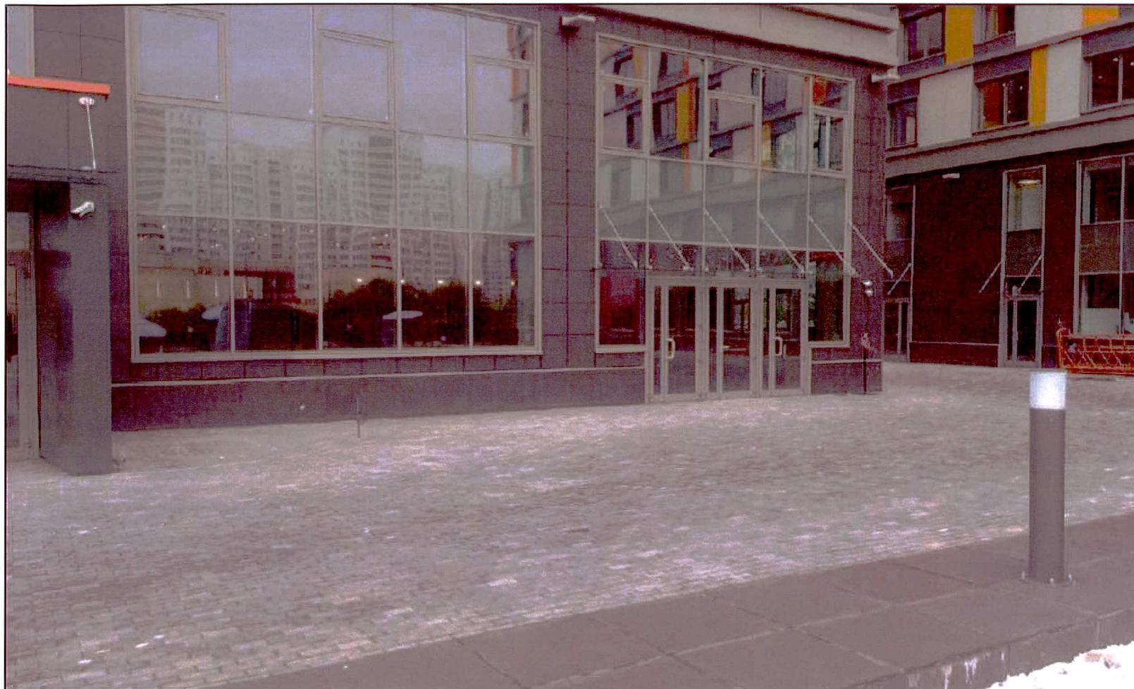
Существующее положение. Вид 1
