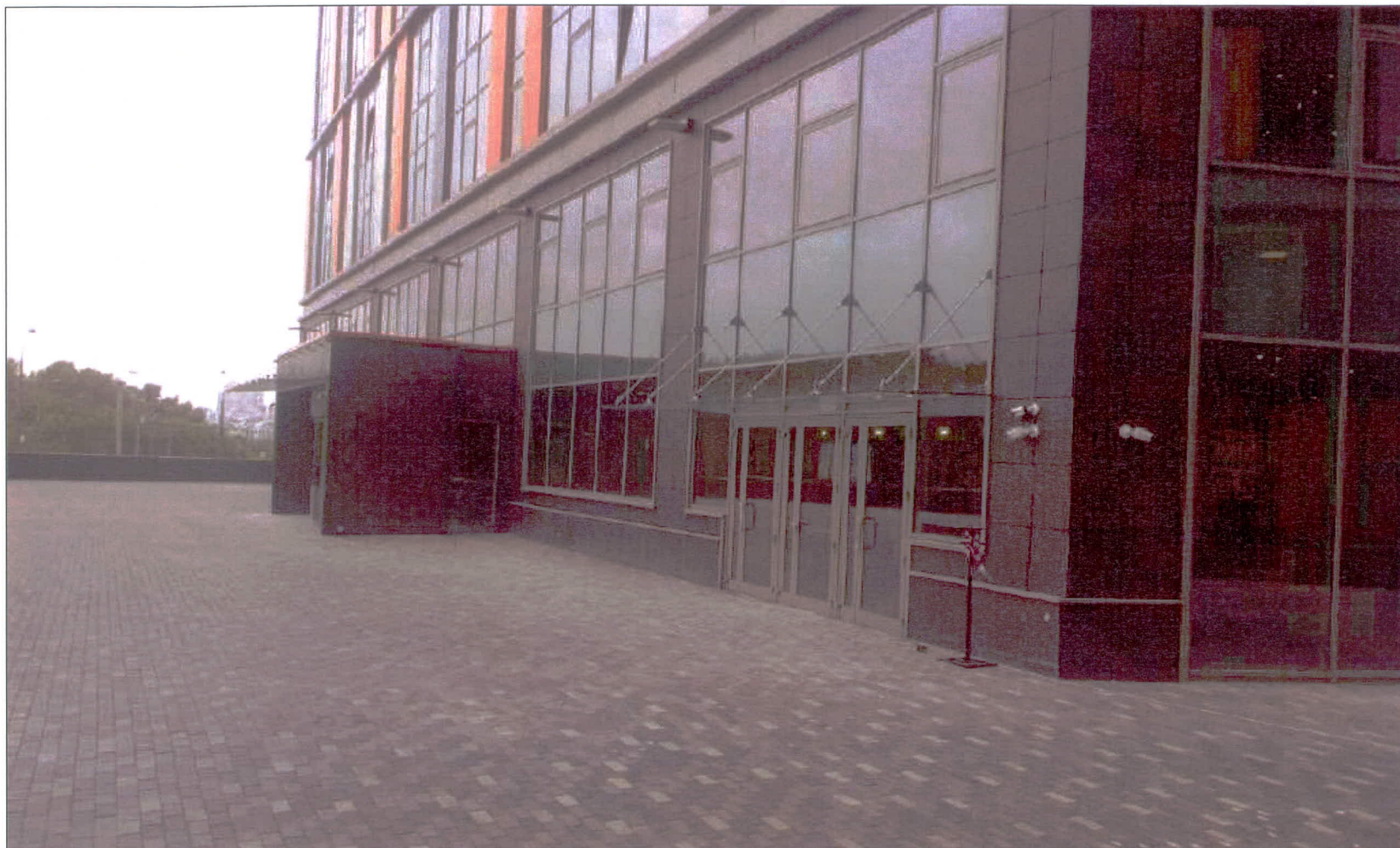
Существующее положение. Вид 2
